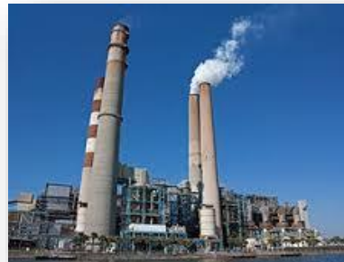
Planta de energía
