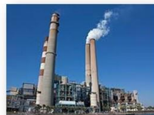
Planta de energía
