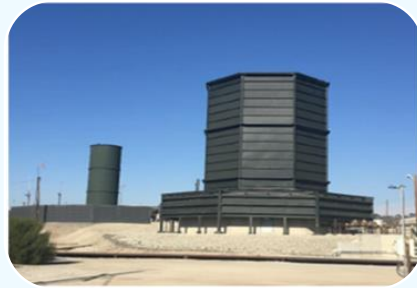
Control de emisiones de quemado en antorcha que no proviene de refinerías
