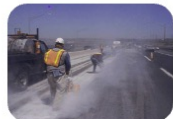
Sitios de construcción
