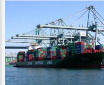
Fuentes de energía eléctrica en puerto
